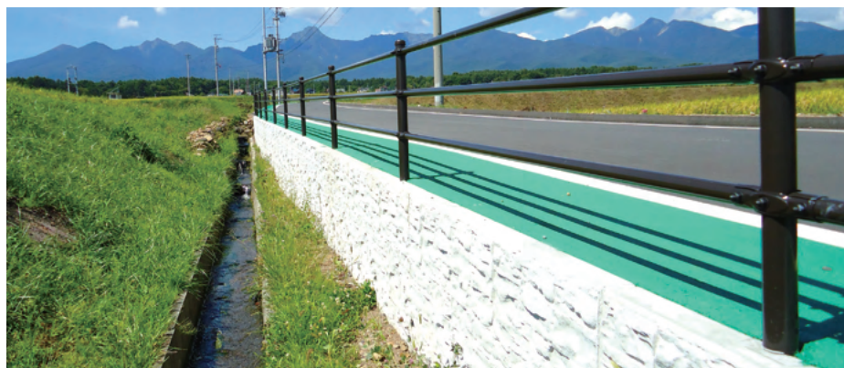
※写真：L型擁壁H1000
